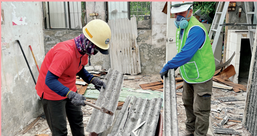
拆除破損屋頂的石棉瓦與天花板
