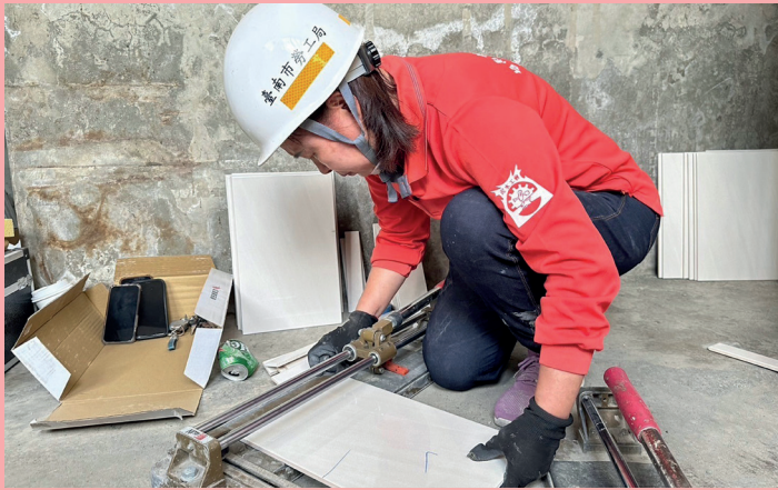
浴室重新貼磁磚，並修補地面、牆壁裂縫
