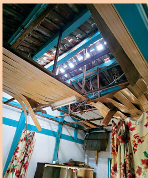
江老太太家的屋頂破損塌陷，十分危險
